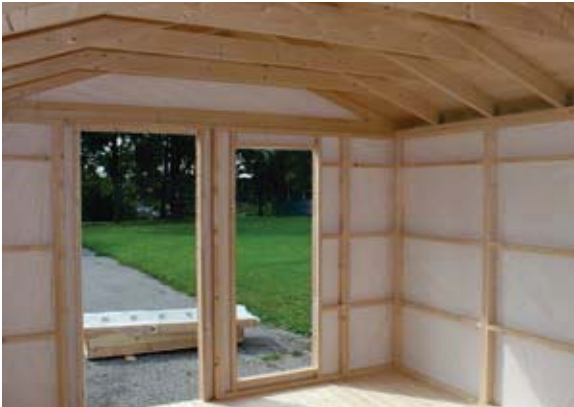
Vue intérieure, murs couverts avec une protection Pare-vent
