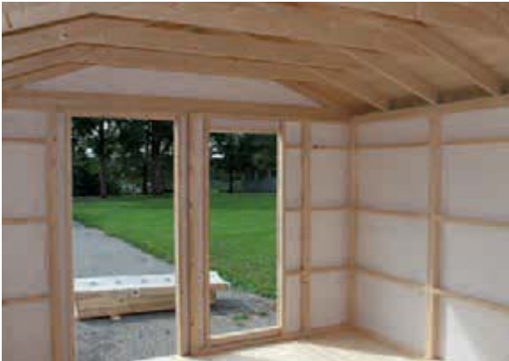
Vue intérieure, murs couverts avec un film pare-vent
