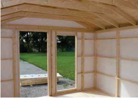
Innenansicht, Wände mit Windschutzfolie
