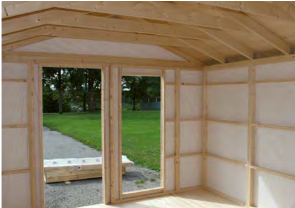
Innenansicht, Wände mit Windschutzfolie
